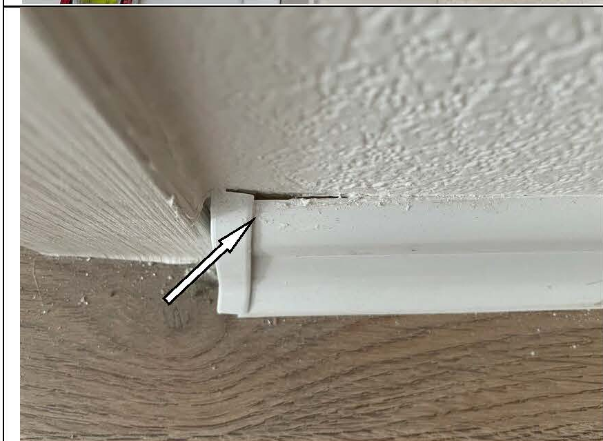
Фото №17. Неплотное прилегание плинтуса ПВХ к стене в спальне.
