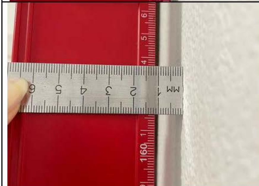
Фото №5. Измерение уровня стен коридора в квартире.
