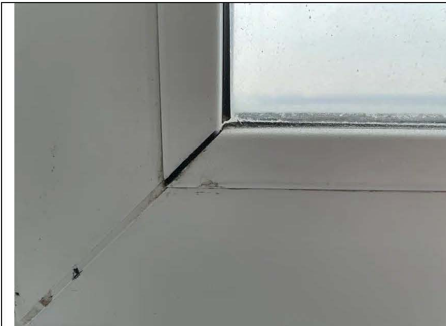
Фото №40. Дефект профиля оконного блока на кухне квартиры.
