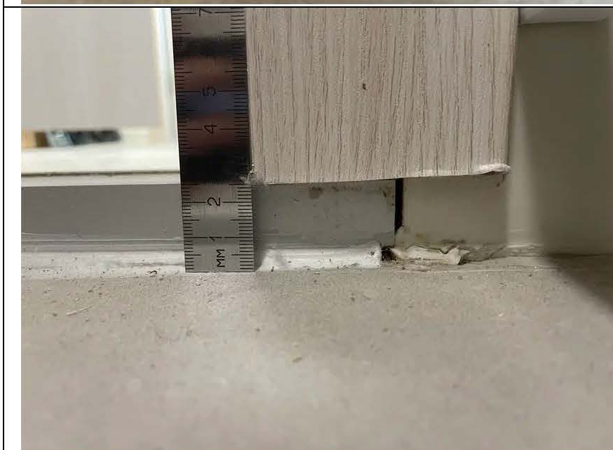
Фото №32. Коротко подрезан наличник дверного блока санузла.
