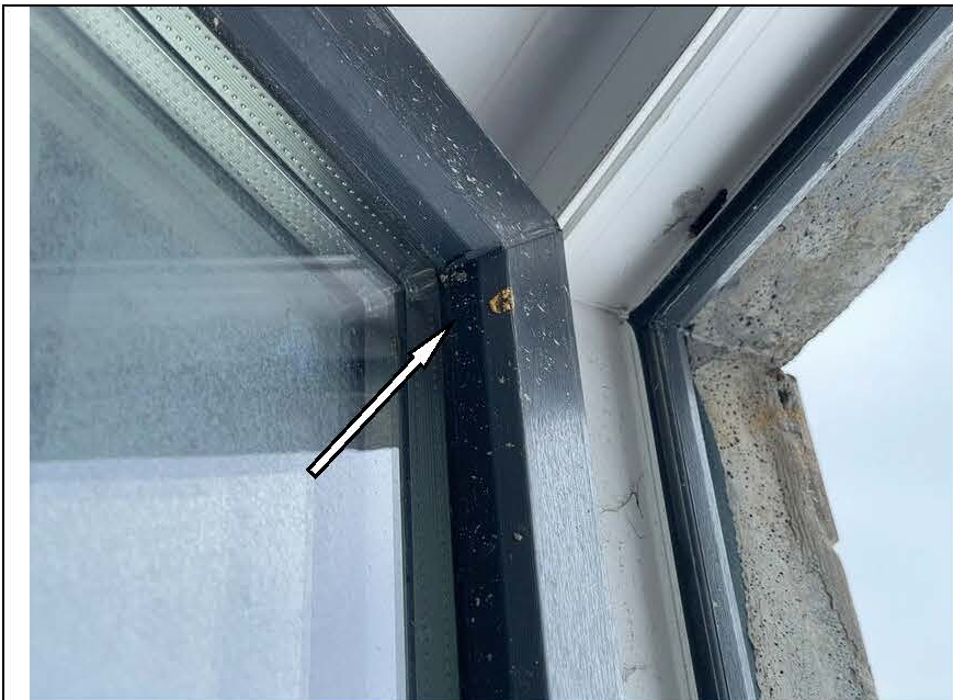
Фото №25. Загрязнение рамы оконного блока в спальне квартиры
