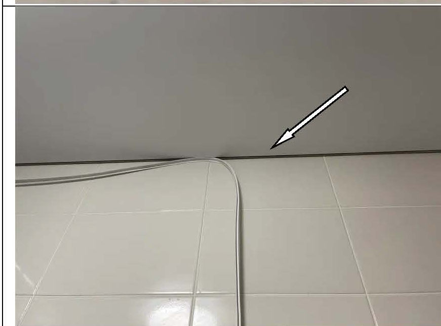
Фото №33. Открепление гибкой вставки натяжного потолка в санузле квартиры.
