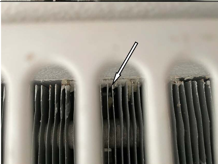
Фото №24. Загрязнение радиатора на кухне квартиры.
