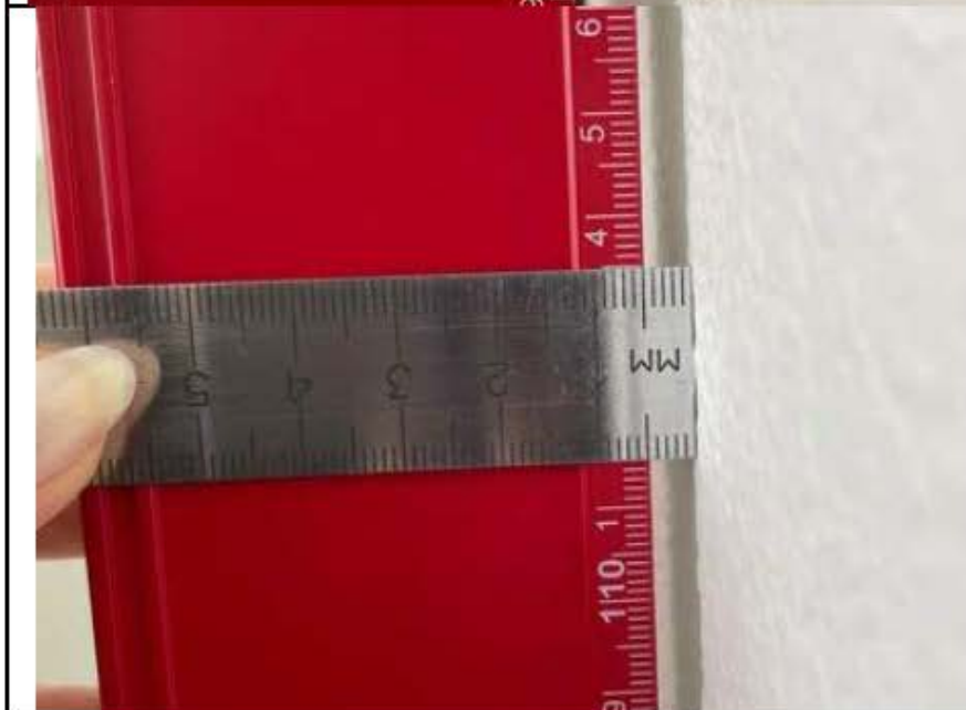
Фото №6. Измерение уровня стен кухни в квартире.
