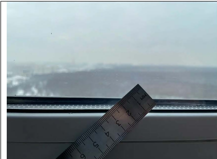
Фото №19. Царапина на стеклопакете оконного блока в спальне квартиры.
