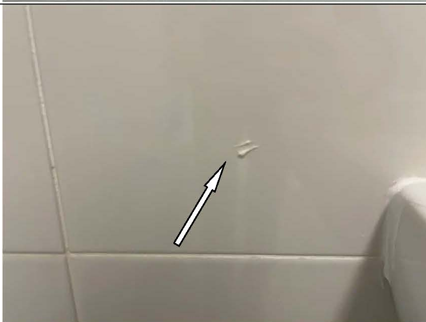
Фото №35. Загрязнение настенной керамической плитки в санузле квартиры.
