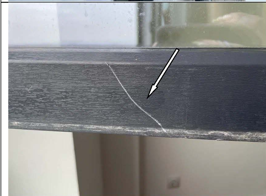
Фото №26. Загрязнение рамы оконного блока в спальне квартиры
