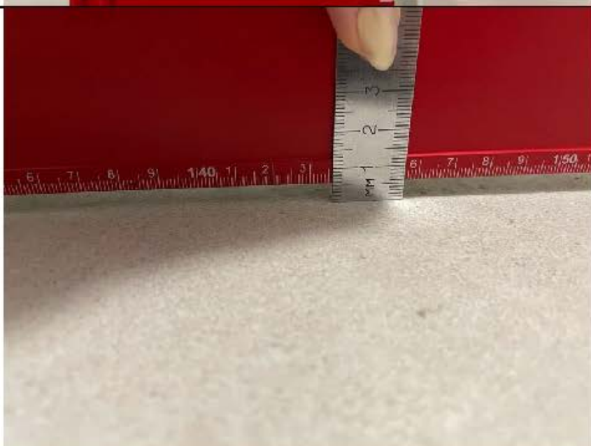
Фото №14. Измерение уровня плитки пола санузла в квартире.
