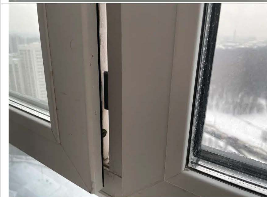
Фото №41. Дефект регулятора створок оконного блока на кухне квартиры.
