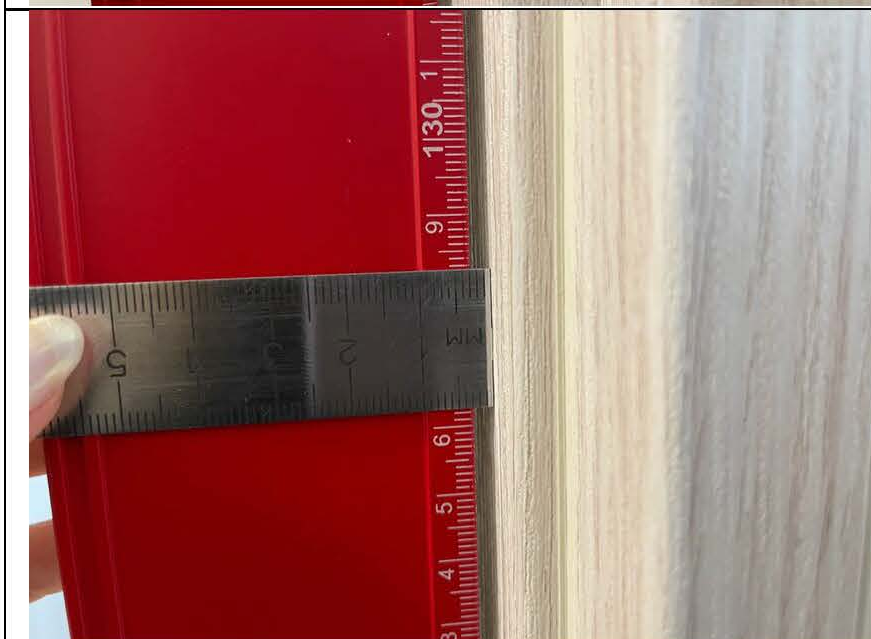
Фото №11. Отклонение наличников на кухне.
