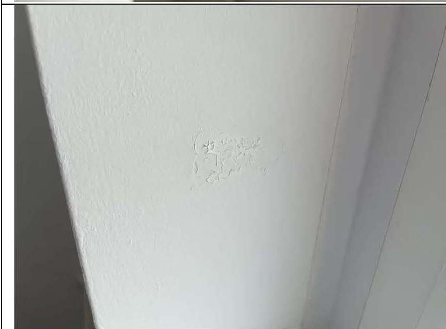
Фото №27. Дефект окрашенного откоса оконного блока в спальне квартиры.
