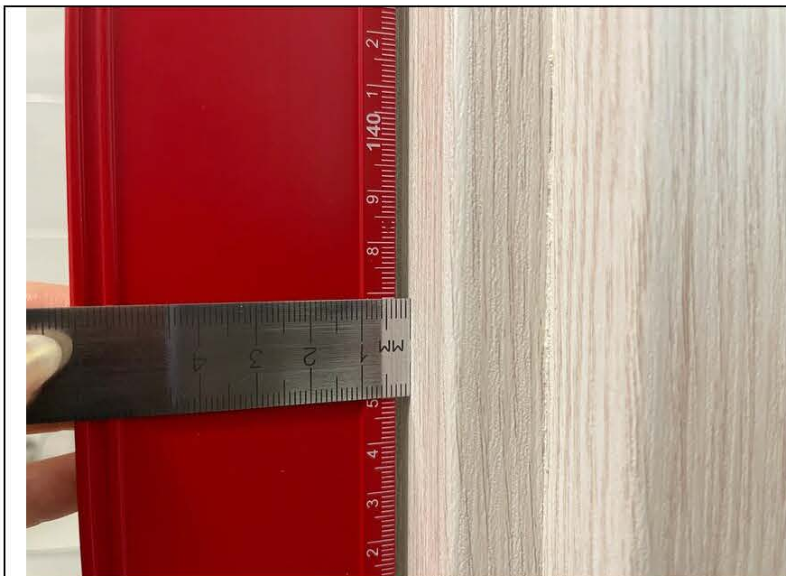
Фото №10. Отклонение наличников в санузле.
