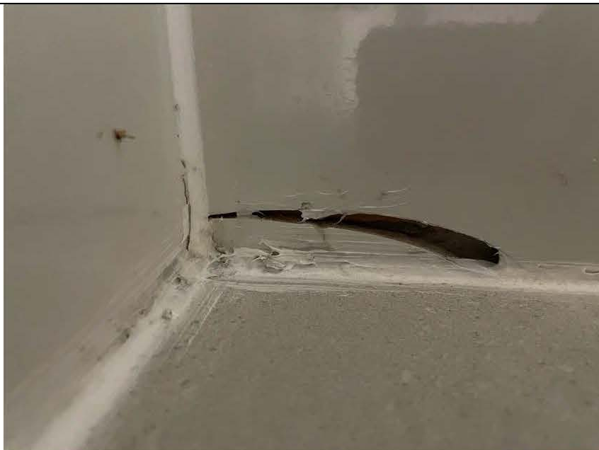
Фото №37. Трещина настенной керамической плитки в санузле квартиры.
