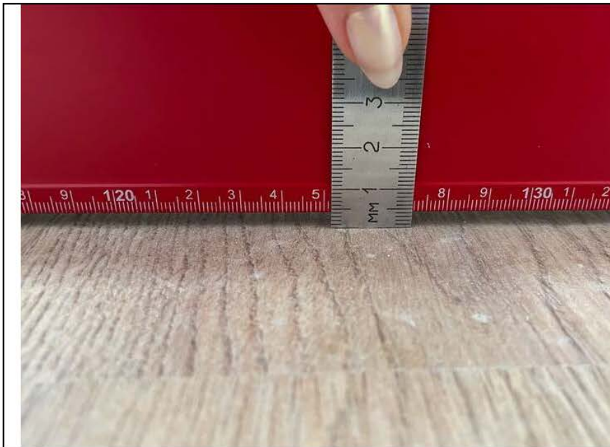
Фото №7. Измерение уровня пола спальни в квартире.
