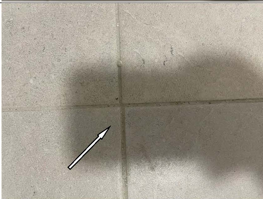
Фото №36. Непараллельный шов напольной керамической плитки в санузле квартиры.
