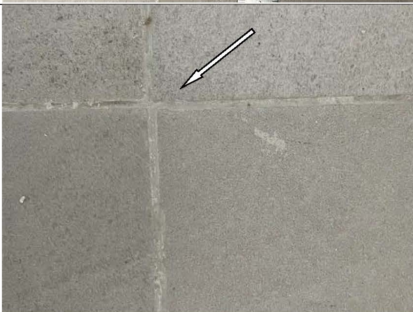
Фото №30. Неровный шов напольной плитки на кухне квартиры.
