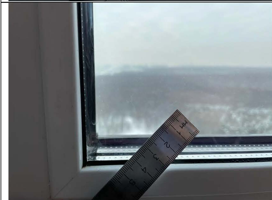
Фото №20. Царапина на стеклопакете оконного блока в спальне квартиры.
