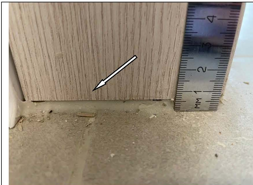
Фото №31. Коротко подрезан наличник дверного блока кухни.
