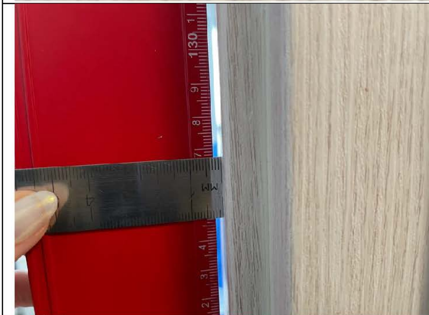
Фото №8. Отклонение наличников в спальне.
