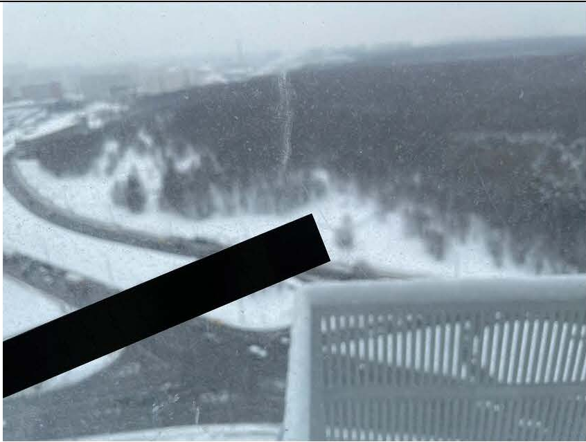
Фото №22. Царапина на стеклопакете оконного блока на кухне квартиры.
