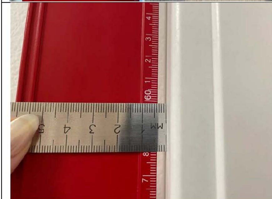
Фото №9. Отклонение наличников входного дверного блока квартиры.
