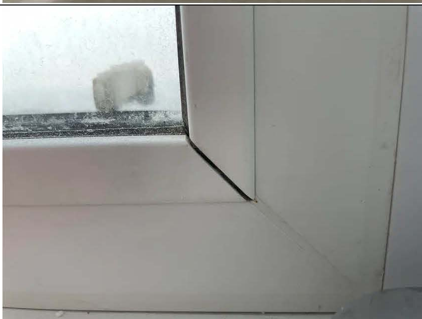
Фото №38. Дефект профиля оконного блока на кухне квартиры.
