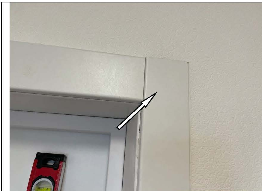
Фото №16. Загрязнения наличника входного дверного блока в квартире
